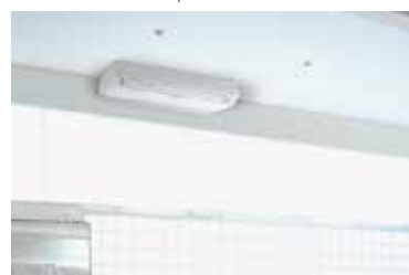
Installation au plafond
